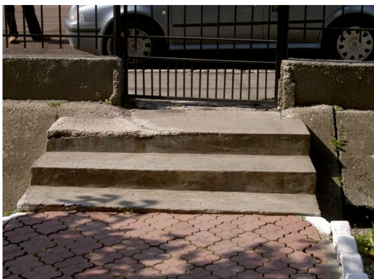
Aus/Eingang zu Waisenhaus von Straße Nicht barrierefrei!! – div. Reparaturen erforderlich
